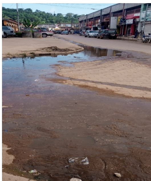
Photo 2 : Une rue commerce du quartier Cité (KONAN O., le 11/01/2024)
