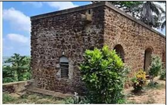
Façade nord-ouest de la porterie du fort
