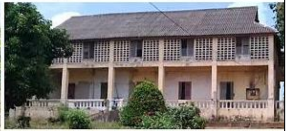
Façade nord de la résidence du fort
