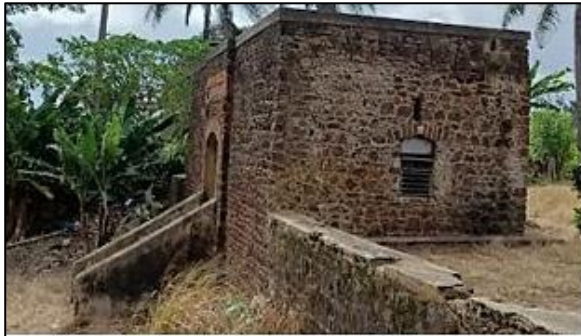
Façade sud-est de la porterie du fort
