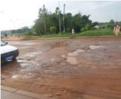
Planche 1 : voie dégradée à San Pedro (voie principale des gares routières au Rond-point Cité)
