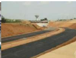
Planche 6 : Prolongement du Boulevard Mitterrand - Bingerville
