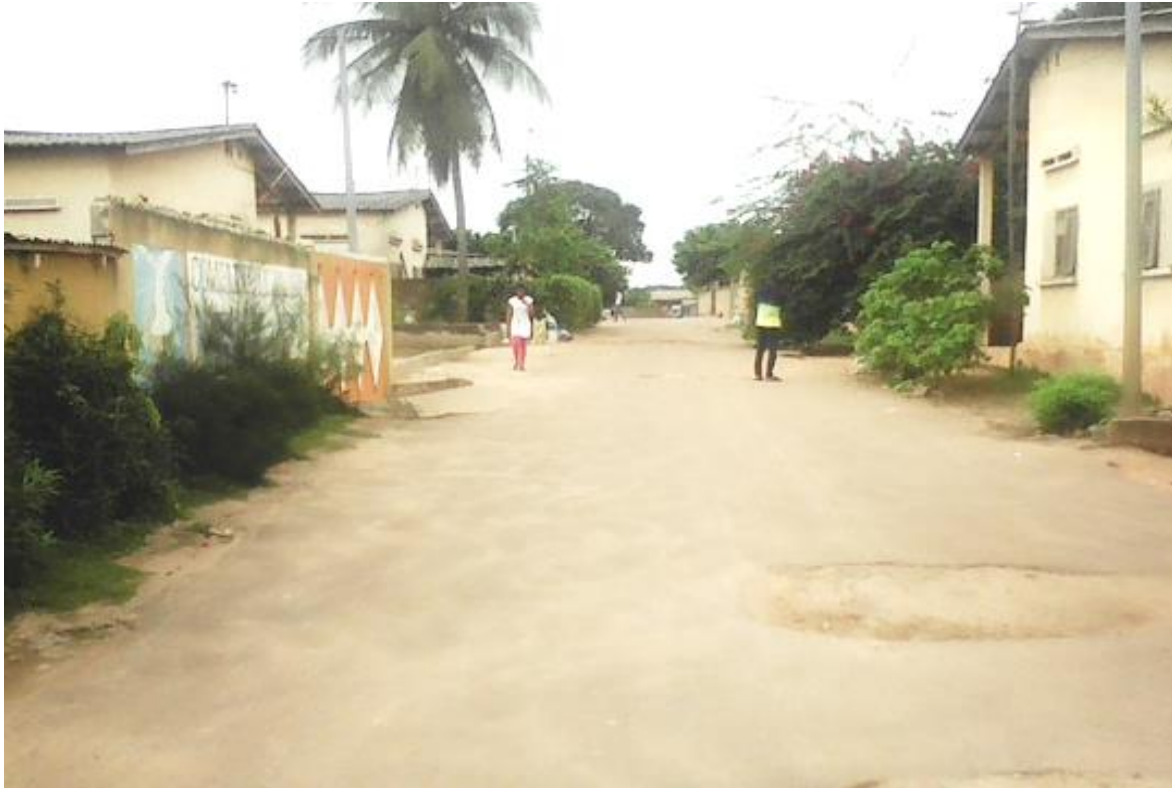
Photo 10 : Une voie intérieure du quartier Habitat, non loin du château d'eau (Konan O., 2016)
