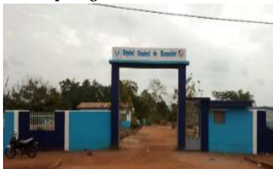
Photo 1 : L'hôpital général de Kounahiri
