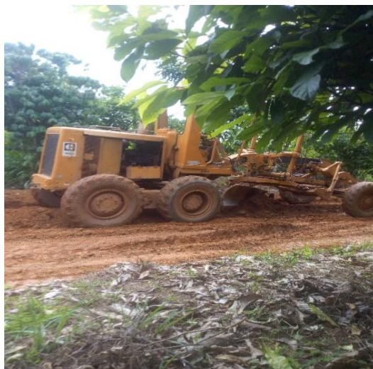
Photo 2 : Reprofilage de route à Poréagui
