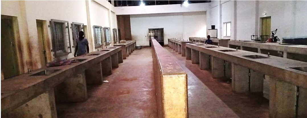
Photo 2 : Stand de traitement des produits halieutiques avant stockage
